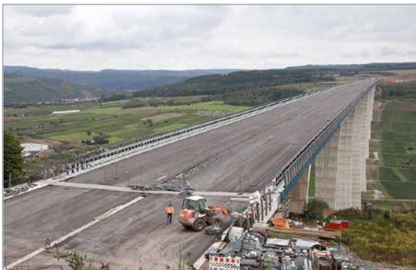
Hochmoselbrücke Zeltingen-Rachtig, 2019: Fertigstellung der Asphaltdecke und der Windleitwände © Manfred Silwanus/LBM Trier. ( http://www.hochmoseluebergang.rlp.de )
