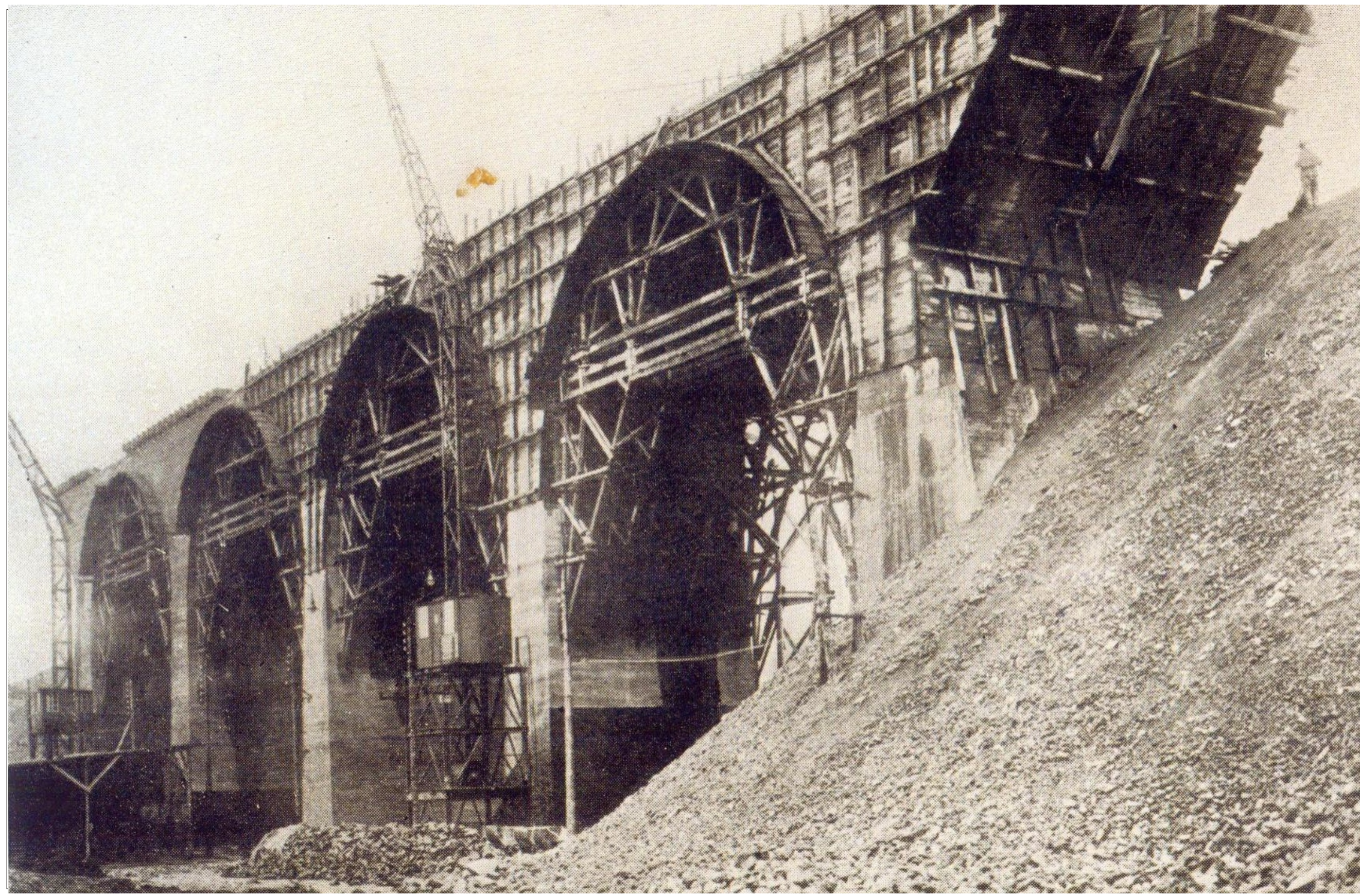
Bau der Bahnbrücke bei Braunlauf (1916). Construction du pont ferroviaire près de Braunlauf (1916). Bouw van de spoorwegbrug nabij Braunlauf (1916).
