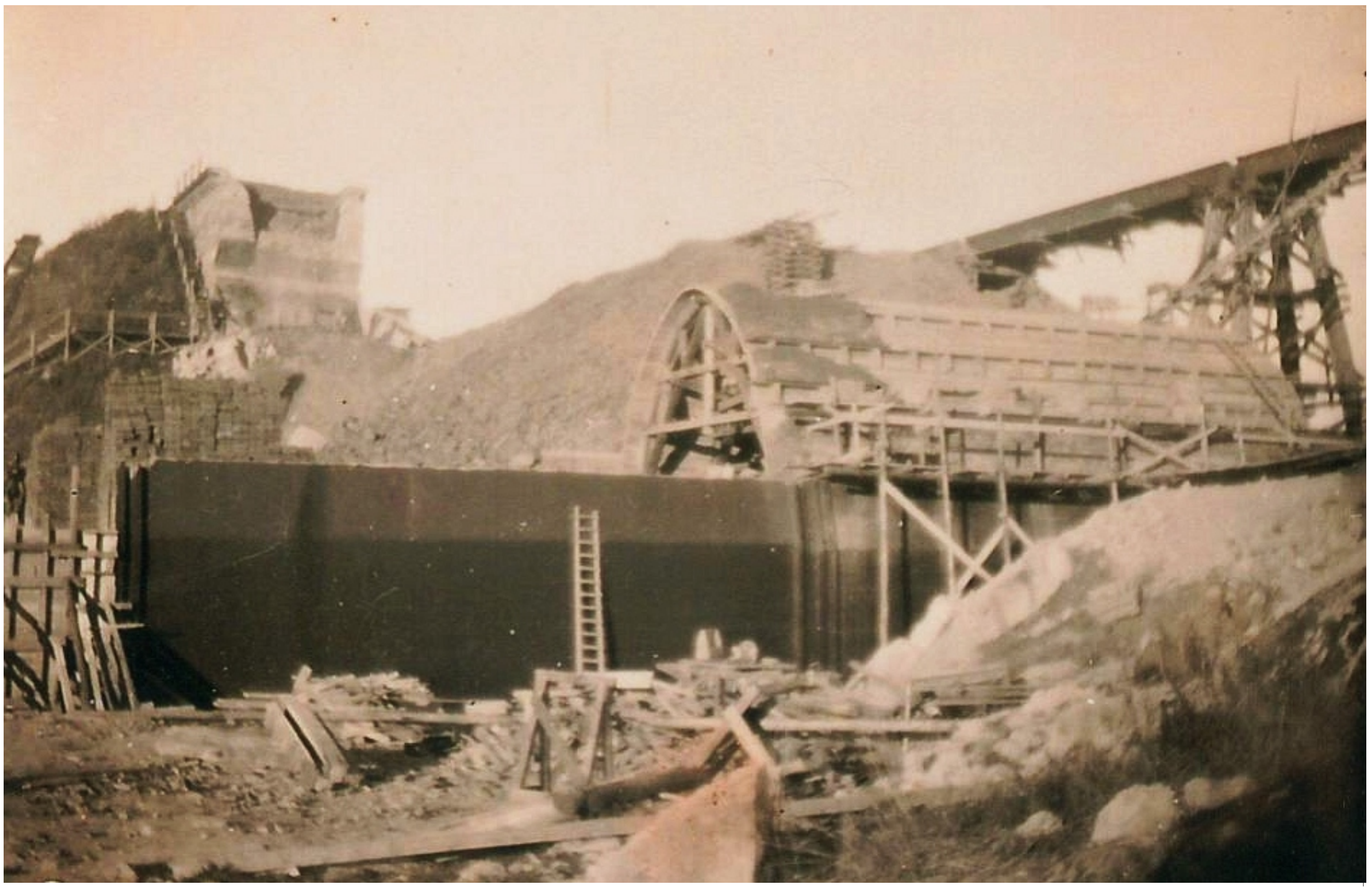
Provisorische Brücke und Bau des heutigen Tunnels (1940-41). Pont provisoire et construction du tunnel actuel (1940-41). Tijdelijke brug en bouw van de huidige tunnel (1940-41).
