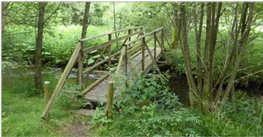
Die 2012 neu errichtete Jonnybrücke. An dieser Stelle und auch weiter bachaufwärts bildet nicht die Olef, sondern die Böschungskante auf deutscher Seite die Grenze. Die Brücke liegt somit vollständig auf belgischem Gebiet. (Foto: Archiv Geschichtsruppe Rocherath-Krinkelt, 2016)
