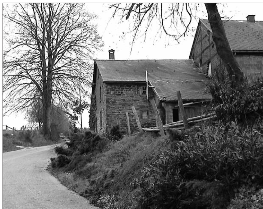
Mehrere Anbauten haben das Aussehen des kleinen Hauses verändert, das Maria Susanna Kartheuser 1822 übertragen worden war. (Sammlung Norbert Thunus, Verviers)
