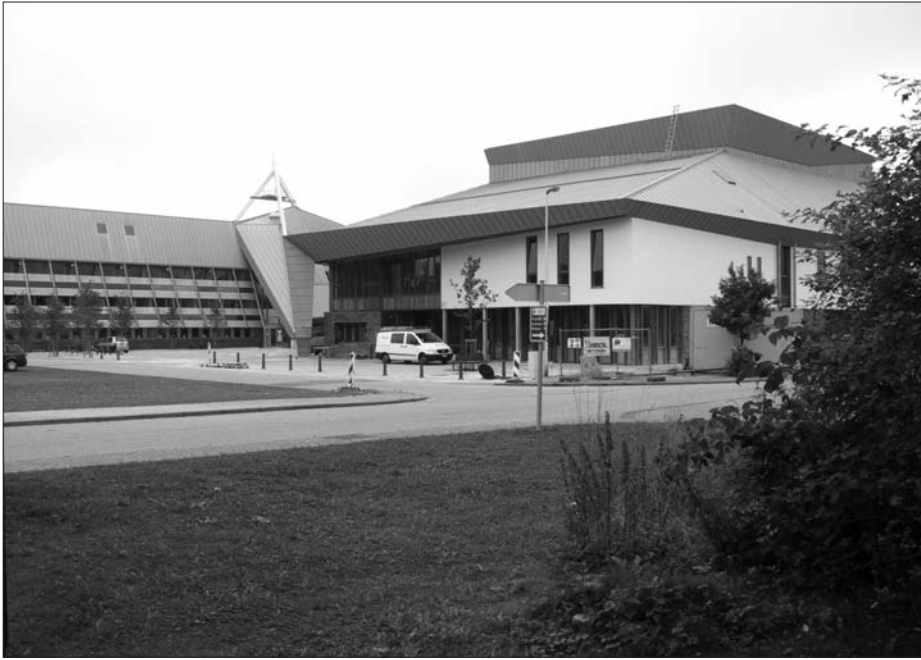
Das Kultur-, Konferenz- und Messezentrum „Triangel“ (vorderes Gebäude); im Hintergrund: das Dienstleistungszentrum der DG. (Foto: KD Klausner)
