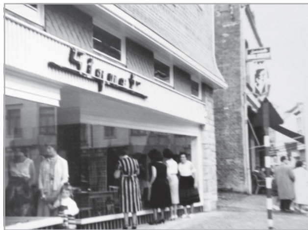
Wohnhaus mit Atelier und Geschäft in der Rue du Commerce in Malmedy (1959).
