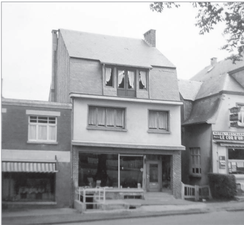
Das Geschäftshaus Siquet am Bahnhof in Malmedy (1949-1956).
