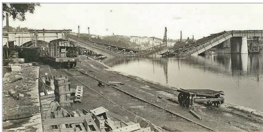
Die von belgischen Pionieren gesprengte Eisenbahnbrücke von Namur.
