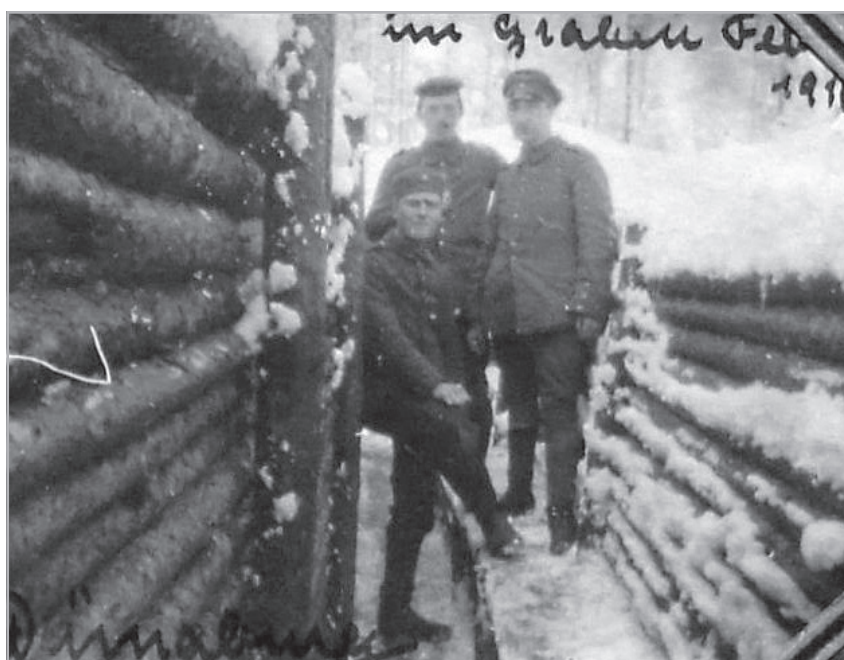
Im Graben vor Dünaburg.
