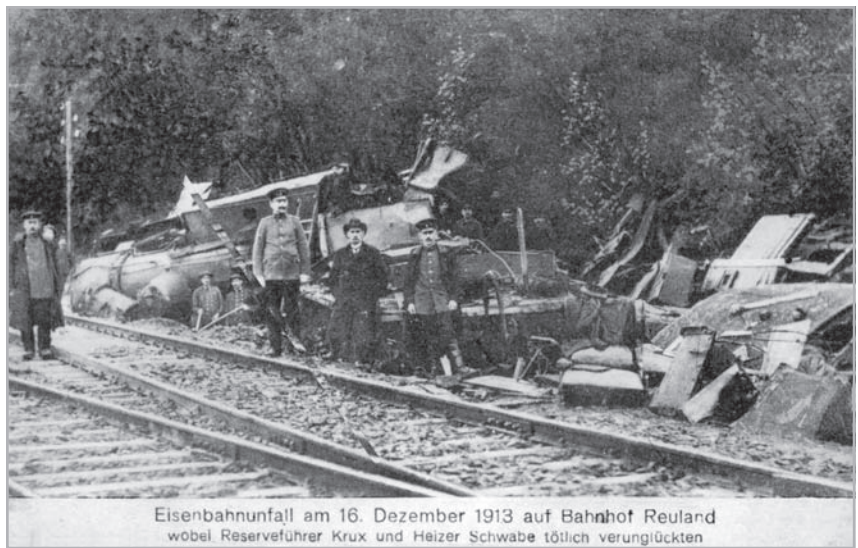
Das Eisenbahnglück vom Dezember 1913 in Reuland.
