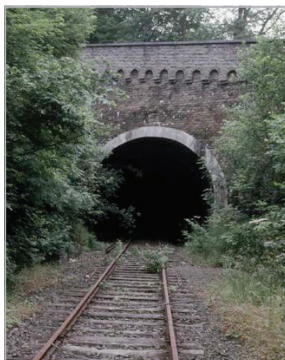
Die von Malmedy kommende Bahnlinie führte durch den 507m langen Tunnel von Berzilliers (Monty) in den Bahnhof Stavelot. (Foto: www.kpn.nl, 19.10.2013)
