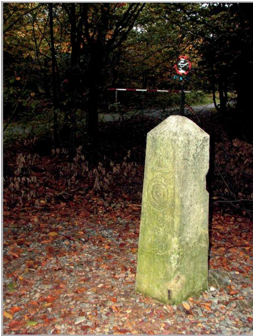
Die Tranchotpyramide auf Botrange. Eingraviert ist ein gleichseitiges Dreieck, die Ziffer 1 (trigonometrischer Punkt) sowie drei Kreise (Messpunkt ersten Ranges). Darunter die Inschrift: BOTRANCHE A TRANCHOT.
