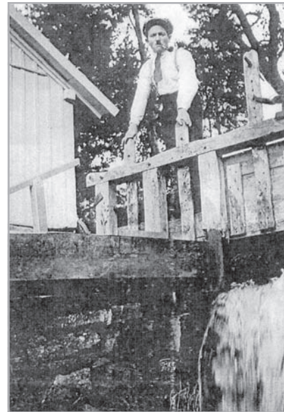
Arthur Renier posiert hier vor dem Schieber, das die Wasserzufuhr zum Antreiben der Mühlräder regulierte. Er war der letzte Müller von Pont. 1940 gab er den Mahlbetrieb endgültig auf. 1970 baute sein Sohn Edgard Renier die Anlage ab. Damals erhielt das Anwesen sein derzeitiges Aussehen.
