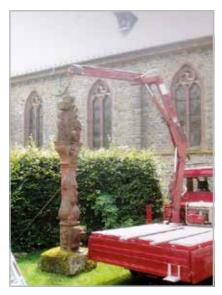
Vor dem Abbau war das Kreuz durch eine eiserne Strebe gesichert, die am Boden in einen Steinblock eingelassen war. Ohne diese Sicherung wäre das Kreuz längst eingestürzt.
