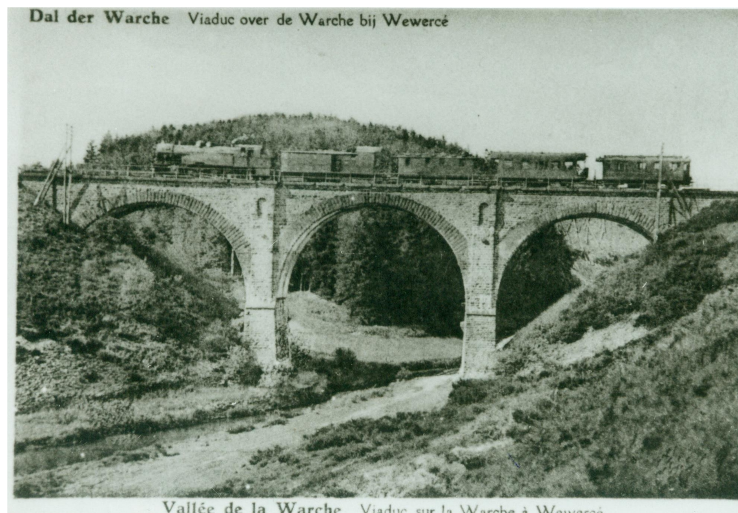
Der Viadukt über das Warchetal (um 1925). Le viaduc enjambant la vallée de la Warche (vers 1925). Het viaduct over het Warchedal (rond 1925).
