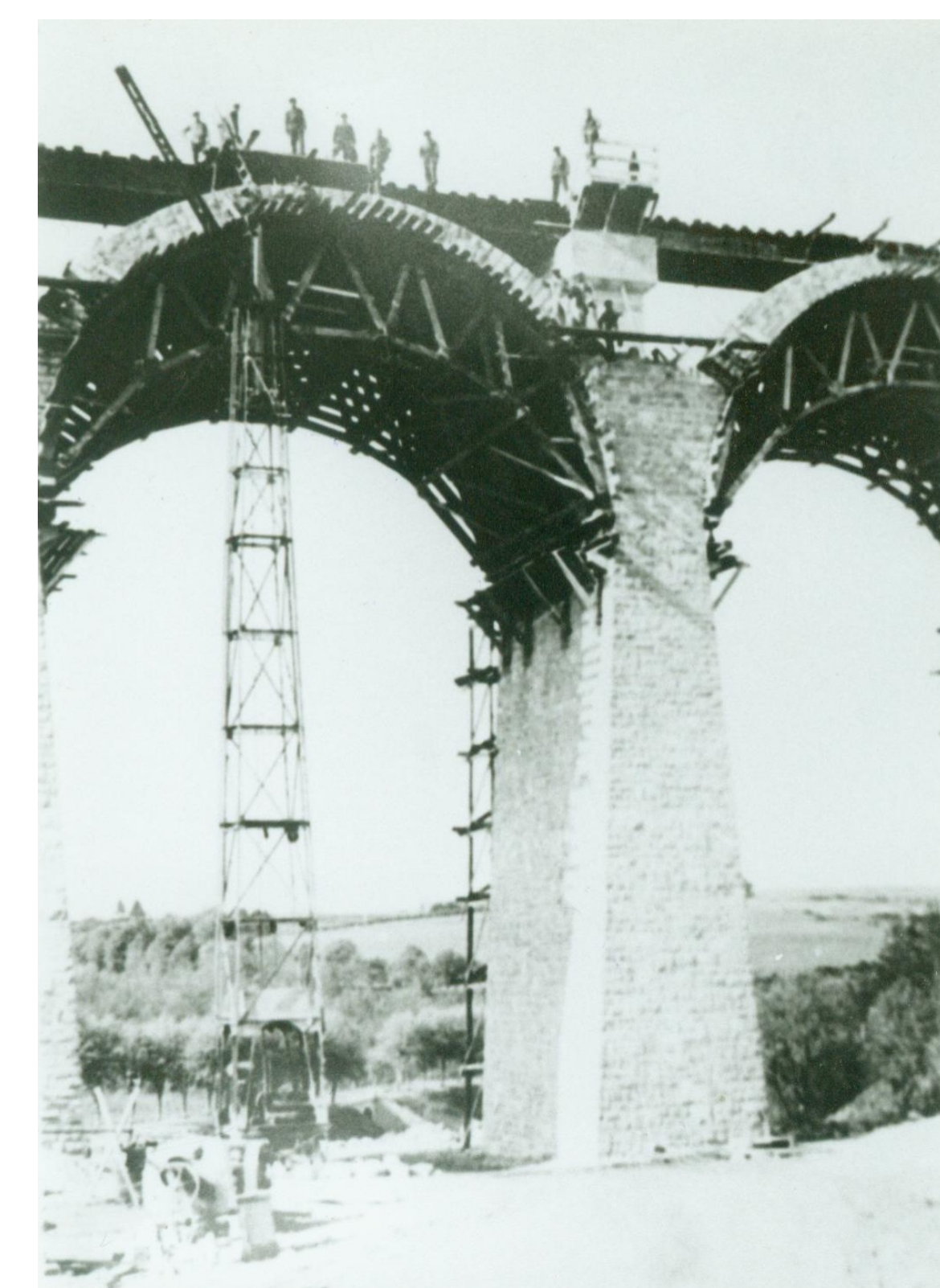
Der Wiederaufbau 1946. La reconstruction en 1946. De heropbouw in 1946.
