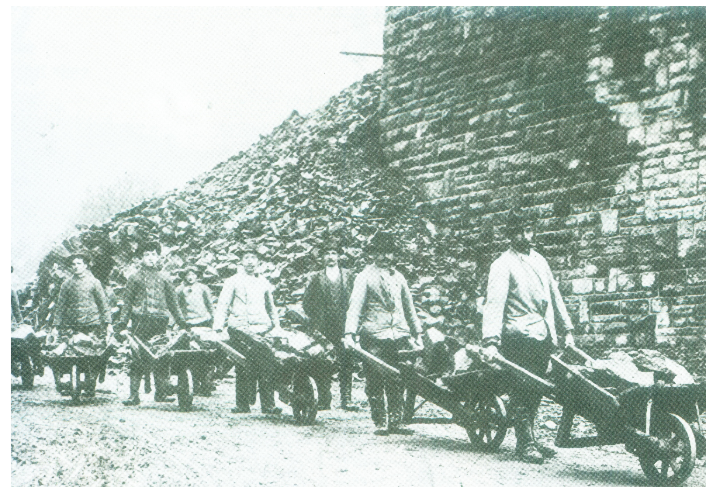
Der Bau der Bütgenbacher Brücke 1910. La construction du viaduc de Bütgenbach en 1910. Oprichting van het viaduct in Bütgenbach in 1910.
