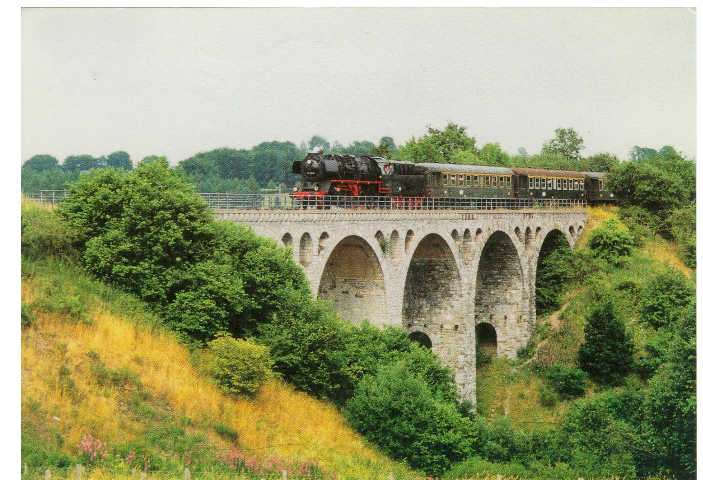
Die Brücke als Kulisse für die touristische Vennbahn (1994). Le viaduc encore jusqu'en 2006 (cliché: mai 1991). Tot 2006 reden er nog houttransporten (opn. 1991).
