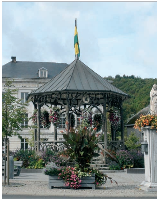
Der heutige Römerplatz (Place de Rome) mit dem Musikkiosk und dem Haus Cavens im Hintergrund. 2013 wurde der Platz einer gelungenen städtebaulichen Umgestaltung unterzogen.
